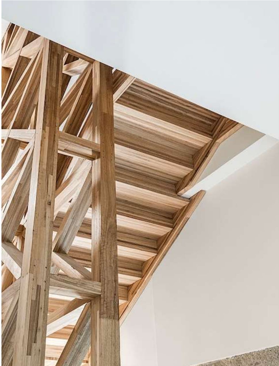
Escaireiras de eucalipto laminado do á sur do conxunto de San Domingos de Bonaval en Santiago de Compostela (A Coruña) - Consorcio da cidade de Santiago de Compostela (2021) | Oficina técnica do Consorcio | Fotografía: Elisa Gallego Picard
